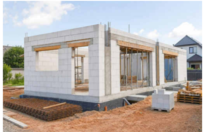
Rohbau eines Massivhauses mit gemauerten Außenwänden, Betondecke und vorbereiteten Fensteröffnungen.
