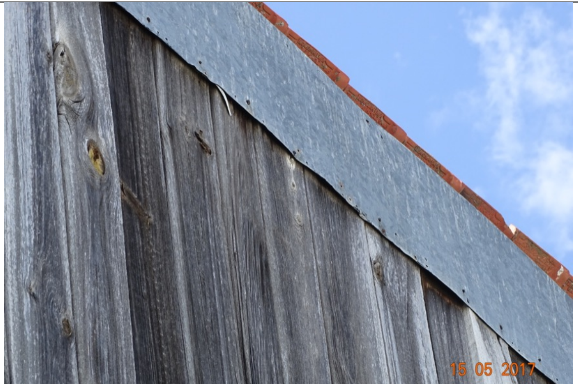
Abb. 9: Bebauungsplan Ziegelgärten VI in Prichsenstadt – Blechverkleidung der Traufe an der Ostseite der Scheune
