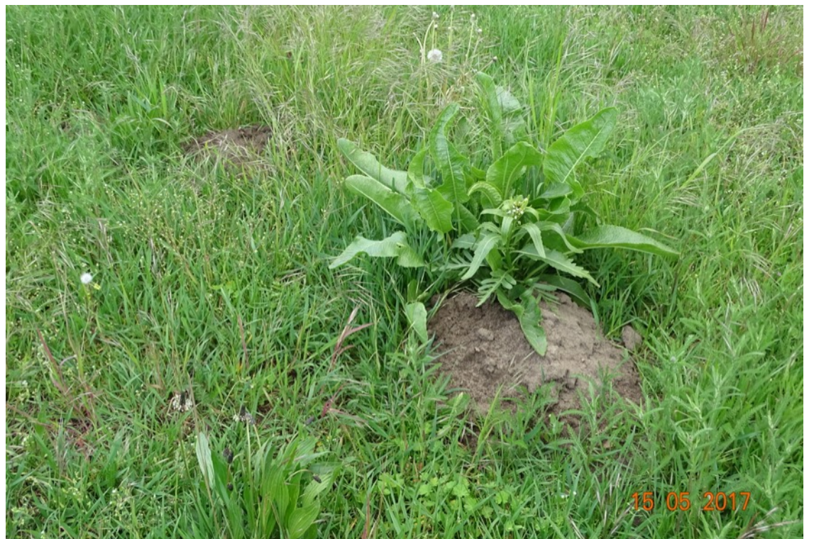
Abb. 14: Bebauungsplan Ziegelgärten VI in Prichsenstadt – sandige Maulwurfs/Wühlmaushaufen auf der Nordseite der Scheune
