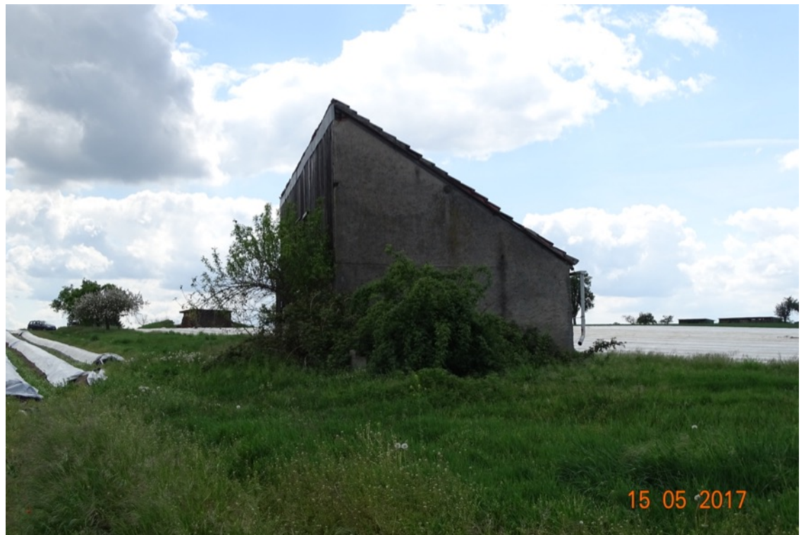
Abb. 4: Bebauungsplan Ziegelgärten VI in Prichsenstadt – Scheunengebäude Nordseite
