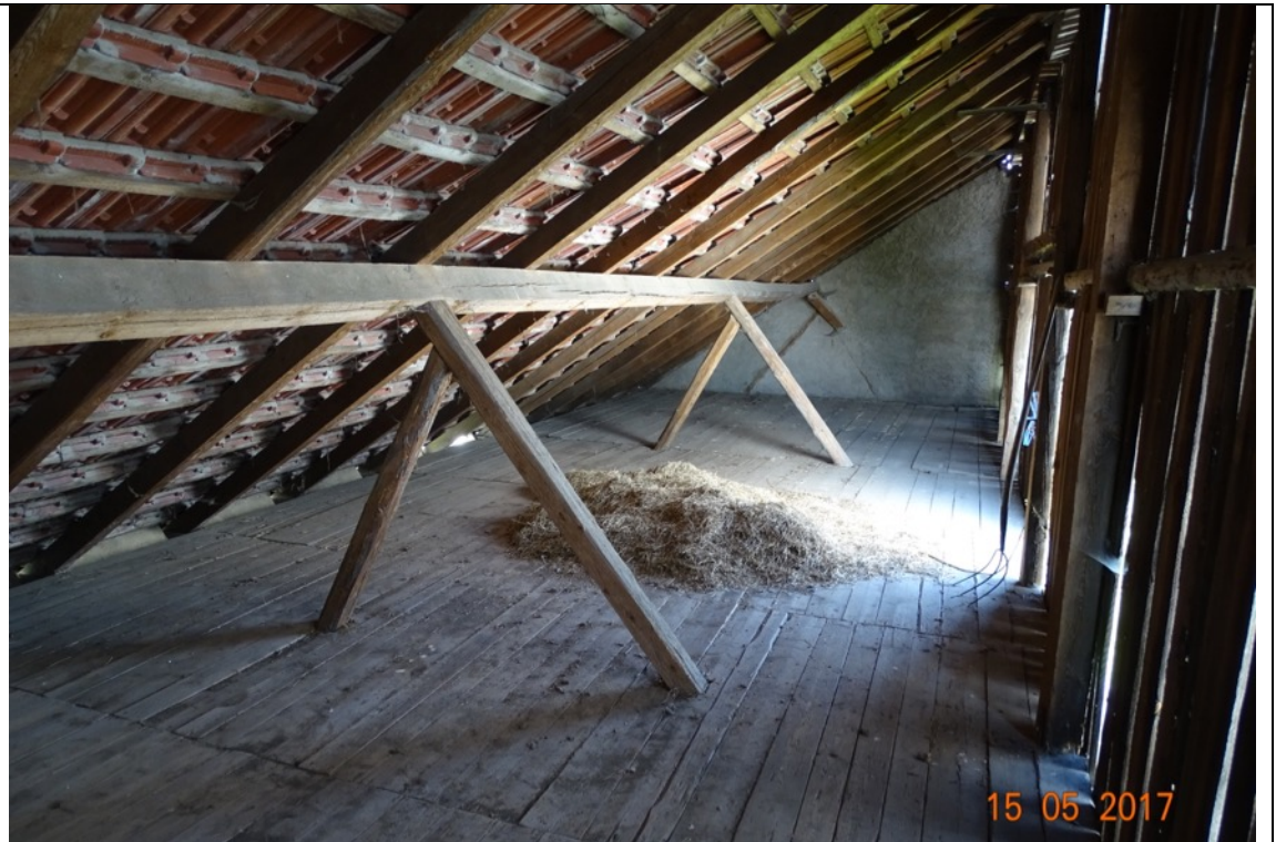
Abb. 7: Bebauungsplan Ziegelgärten VI in Prichsenstadt – Scheunengebäude OG/Dach
