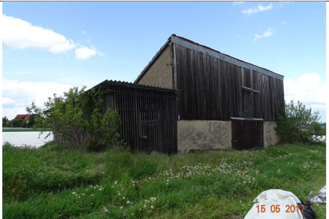
Abb. 3: Bebauungsplan Ziegelgärten VI in Prichsenstadt – Scheunengebäude Süd-/Ostseite
