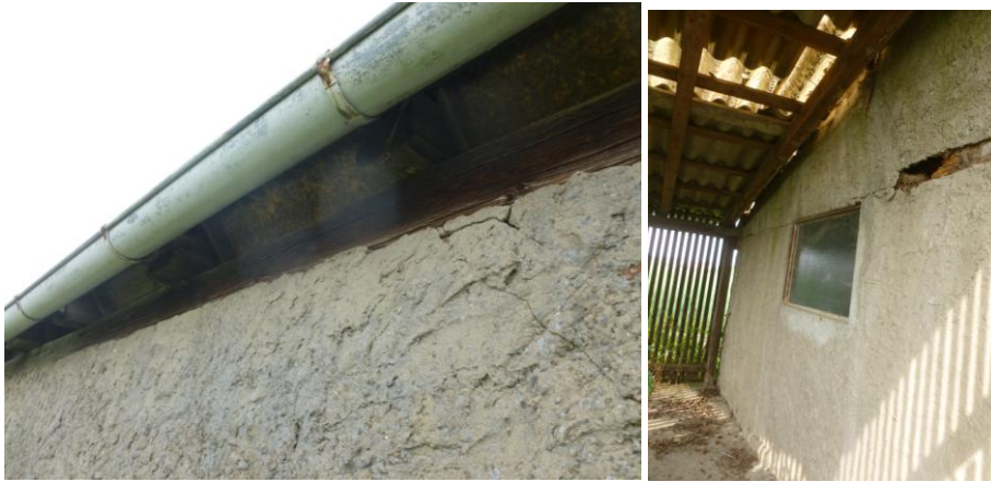
Abbildung 6: Fassadenstrukturen am Scheunengebäude
